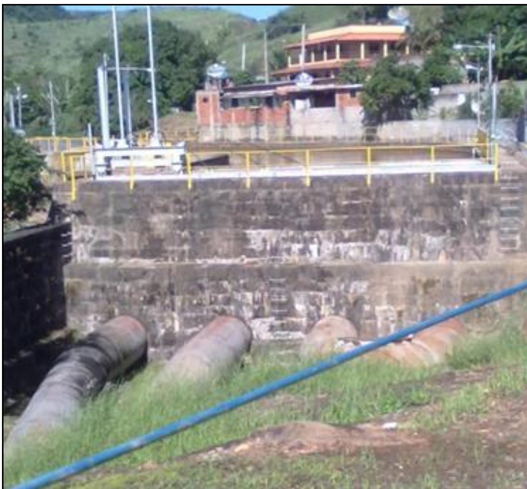
Figura 3.36: Saída da tubulação após a tomada d'água e ao longo do percurso para a casa de máquinas. Fonte: Foto pessoal de 16 de abril de 2013.
