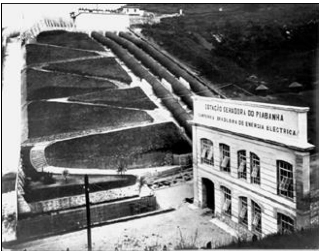
Figura 3.33: Casa de força e tubulação de adução. Fonte: (ME, 2000)
