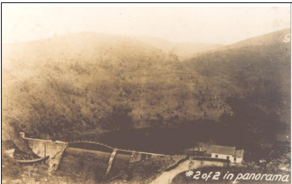
Figura 3.17: Foto Panorâmica da Barragem da PCH Fagundes na década de 20. Fonte: (ME, 2000)
