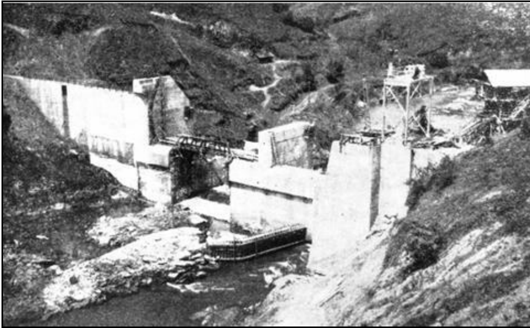
Figura 3.23: Construção da Barragem. Fonte: (ME, 2000)
