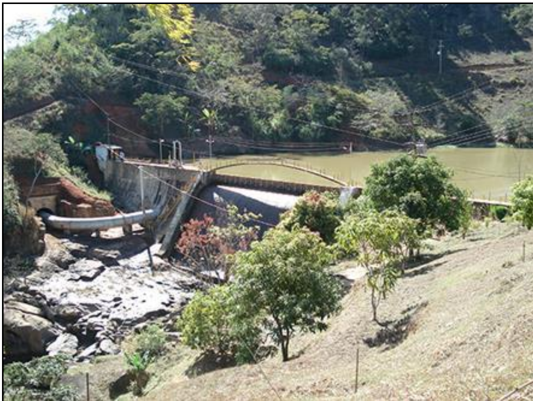
Figura 3.21: Barragem da PCH Fagundes. Fonte: (QUANTA, 2013)
