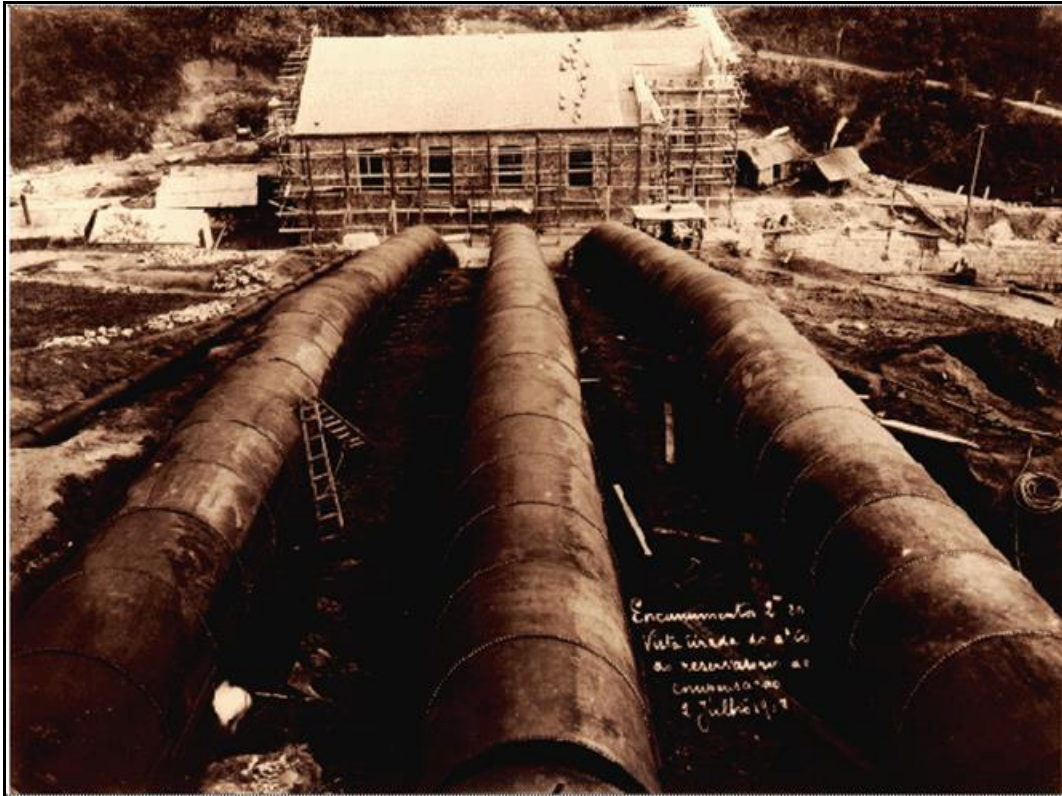
Figura 3.32: Tubulação de adução em construção. Fonte: (ME, 2000)
