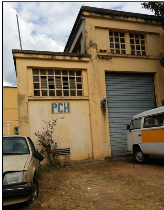
Figura 3.40: Entrada abandonada da Casa de Maquinas. Fonte: Foto pessoal de 22 de janeiro de 2015
