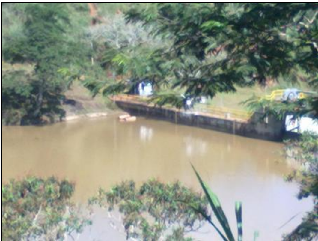
Figura 3.24: Vista para jusante da Barragem Morro Grande. Fonte: Foto pessoal de 16 de abril de 2013.
