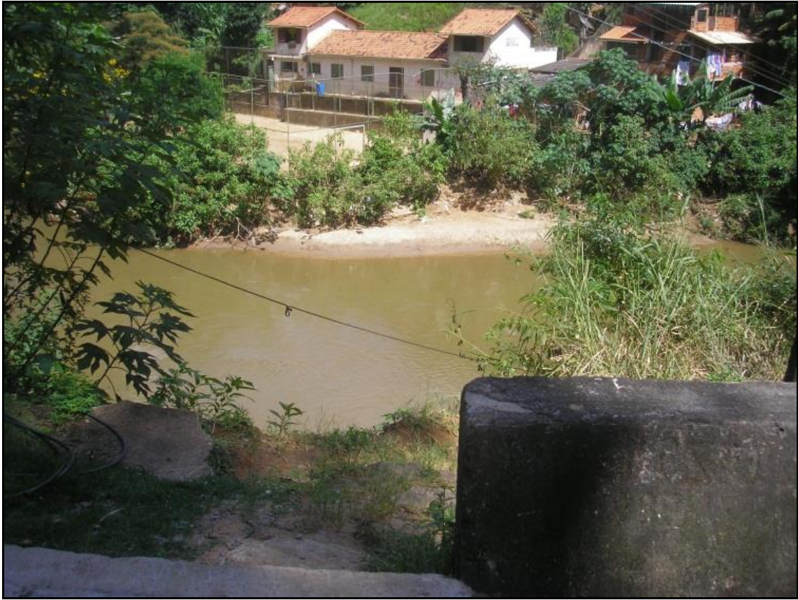
Figura 3.11: Área de lazer construída na faixa marginal do rio. Fonte: Foto pessoal de 21 de novembro de 2013.
