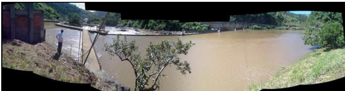
Figura 3.31: Vista panorâmica da Barragem da PCH Piabanha. Fonte: Foto pessoal de 16 de abril de 2013.
