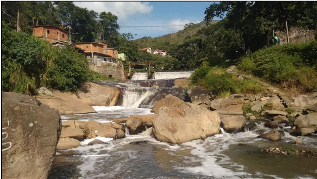
Figura 3.37: Vista de jusante para montante da barragem da CGH Petropolitana. Fonte: Foto pessoal de 22 de janeiro de 2015
