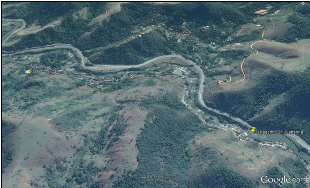
Figura 3.28: Localização da Barragem e da Casa de Máquinas da PCH Piabanha. Fonte: Google Earth, 2014.
